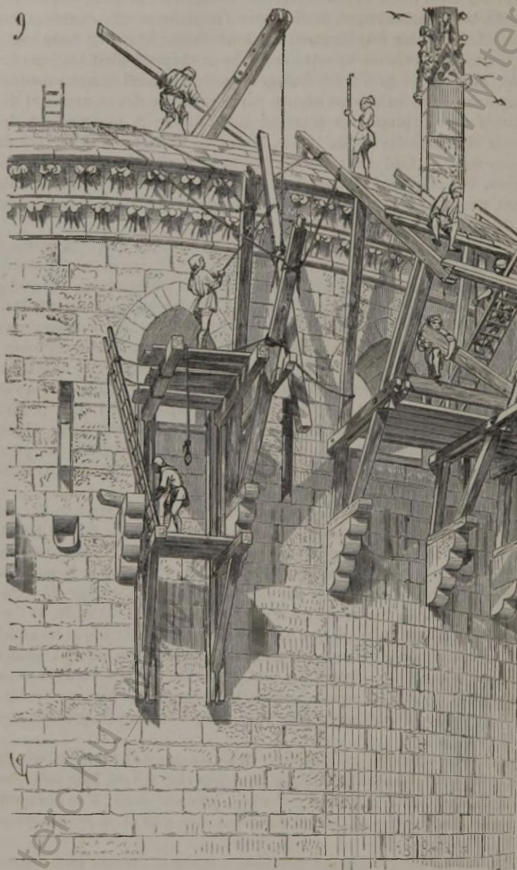
chemise de planches verticales clouées sur les traverses hautes et basses
