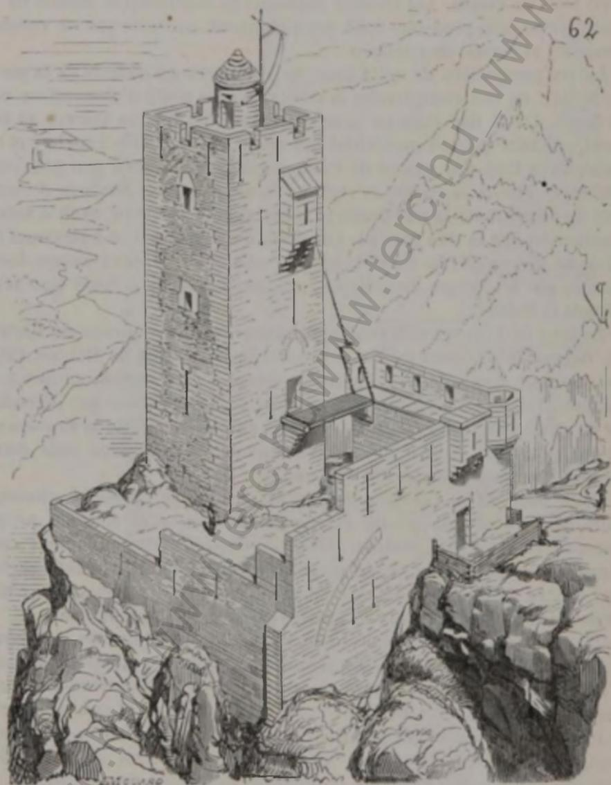
que par une langue de terre, de manière à n'être accessible que vers un point. Cette chaussée naturelle est parfois coupée par un fossé ou défendue par un rempart qui sert de chemise à la tour. On ne peut pénétrer dans l'intérieur de celle-ci que par une porte relevée au-dessus du sol par une échelle ou par un pont volant jeté sur le chemin de ronde
